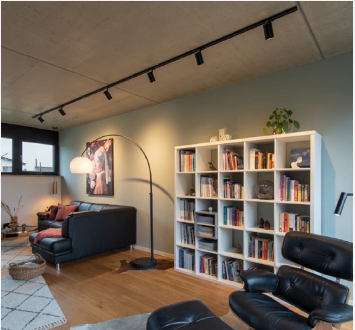
Carriles de superficie monofásicos
